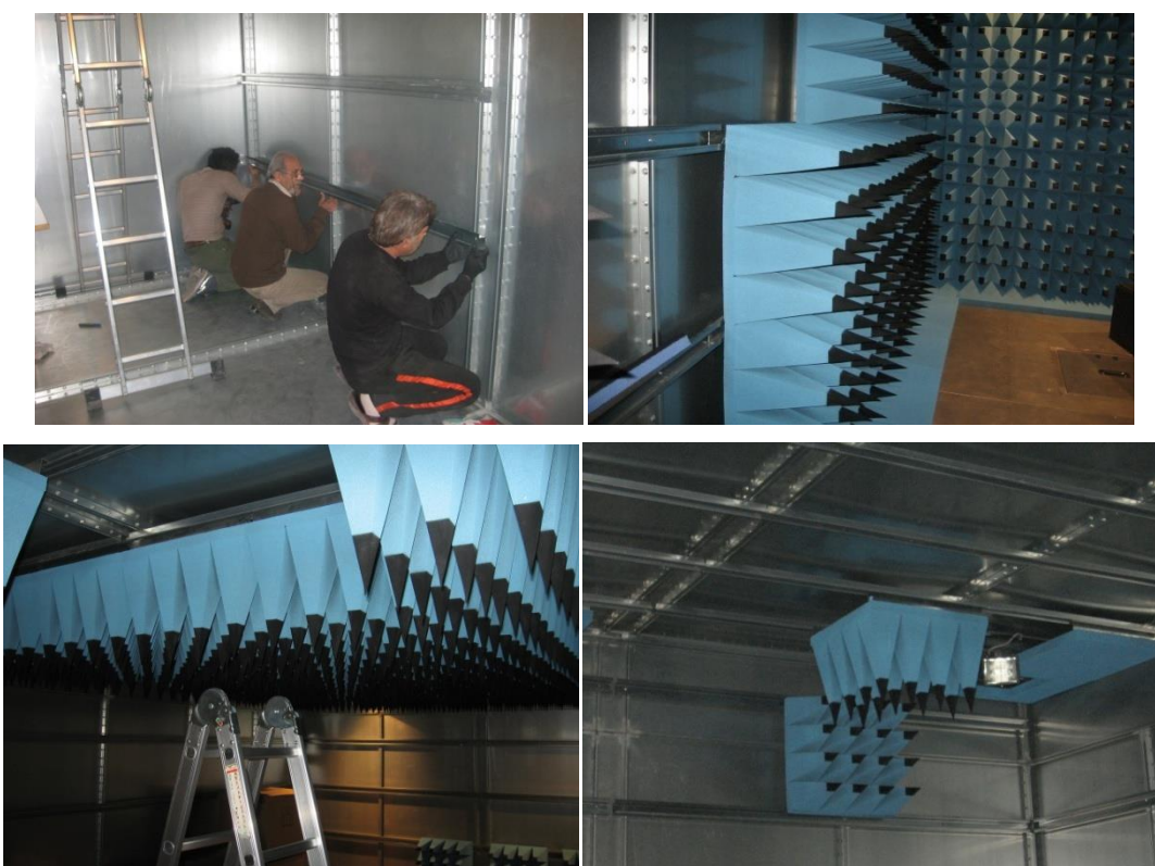
شکل ۴- نصب جاذب‌های دیوارها و سقف با روش ریلی
