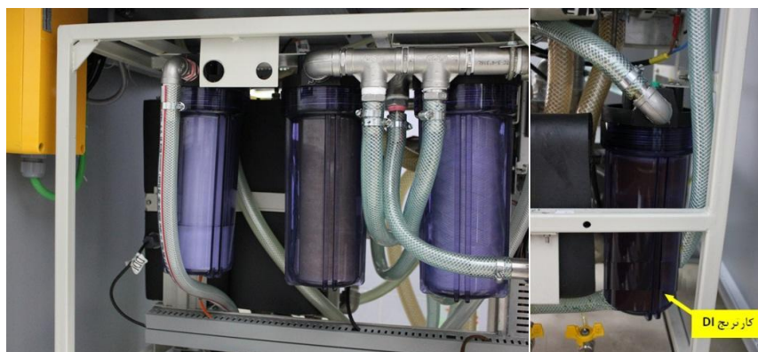
شکل ۹. تصویر هوزینگ کارتریج DI (سمت راست) و فیلترهای ذره (سمت چپ) داخل سامانه خنک‌ساز داخلی
