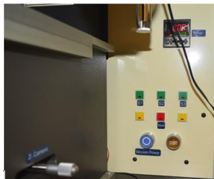
نمایی از کلید های وکیوم نمونه ها، کلید پمپ
